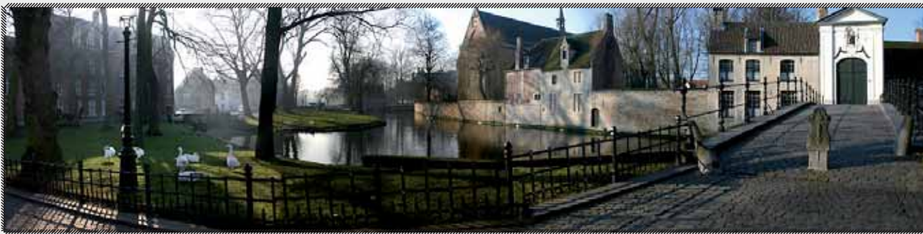
Abb. 14 · Beginenhof in Brügge, Belgien
