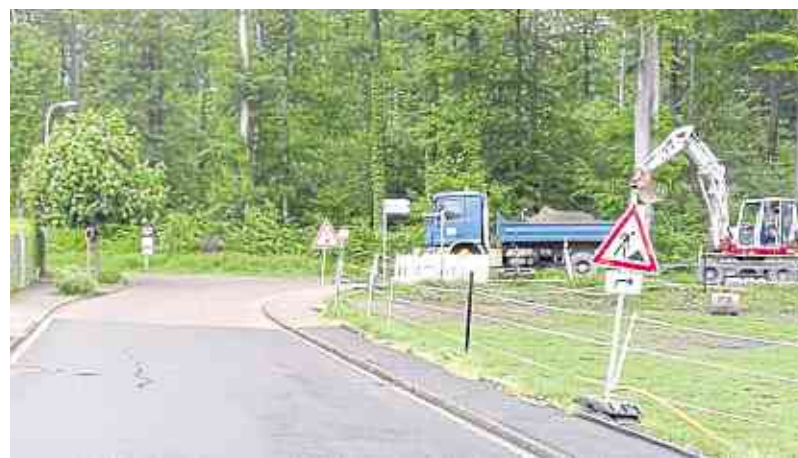
In Horressen wird eine Straßeneinmündung voll gesperrt. Foto: VG Montabaur
