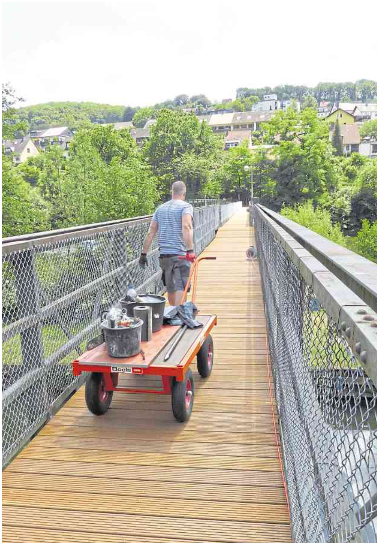
Die Mitarbeiter des Bauhofs haben ganze Arbeit geleistet und die Holzbohlen erneuert. Die ersten Rheinsteig-Wanderer zeigten sich zufrieden mit dem neuen Belag.
